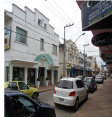
Vista do conjunto de edificações
